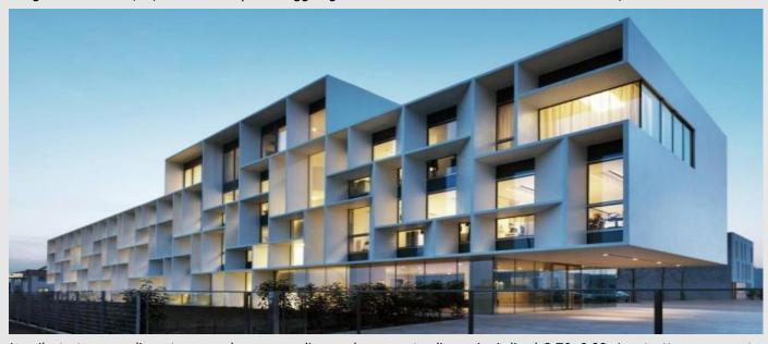
Le pilastrate sono disposte secondo una maglia regolare avente dimensioni di ml 8.70x6.00. La struttura presenta un solo campo trasversale e 10 campi longitudinali oltre due sbalzi terminali rispettivamente di ml 3,00 e 6,00.
