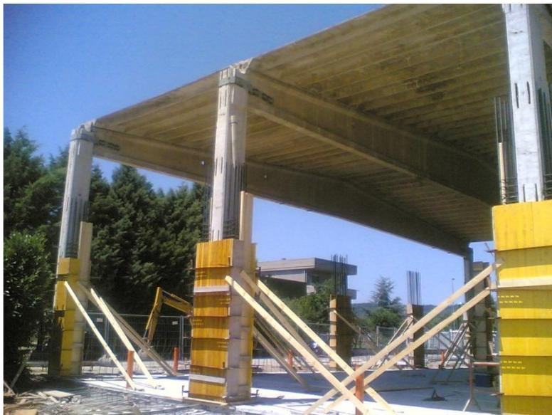
**Struttura orizzontale:** le travi di perimetro e la travata centrale, adiacente alla sala riunioni, sono ribassate, mentre quelle interne sono a spessore solaio. Le travi, tra le colonne esistenti, sono state modellate come elementi semplicemente appoggiati, trascurando qualsiasi contributo all' assorbimento degli sforzi
